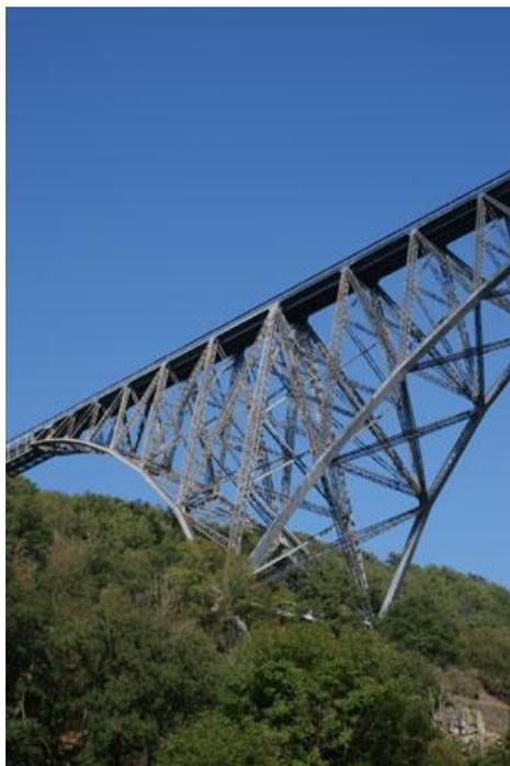
C'est le seul pont de ce type en France. Ce système dit « à arcs équilibrés » ou « à poutres balancées » consiste dans l'adjonction d'encorbellements à la travée centrale qui, par le seul effet de leur contrepoids, allègent la pression qui s'exerce à la clé en équilibrant partiellement le poids de la « poutre » médiane.
